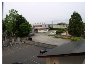
ブロック塀の外側が新駐車場になります。
