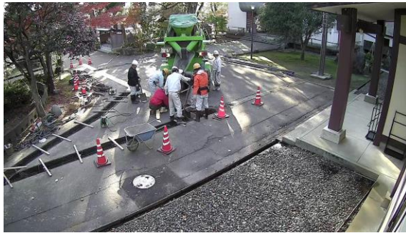
本堂前消雪パイプ敷設工事
